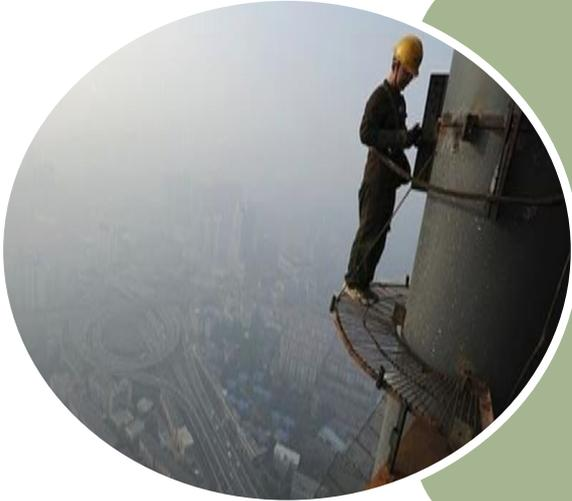
**9. ES EL DISPOSITIVO DISEÑADO PARA SUJETARSE A UN RIEL VERTICAL O LINEA DE VIDA VERTICAL Y DESLIZARSE HACIA ARRIBA Y HACIA ABJO**
